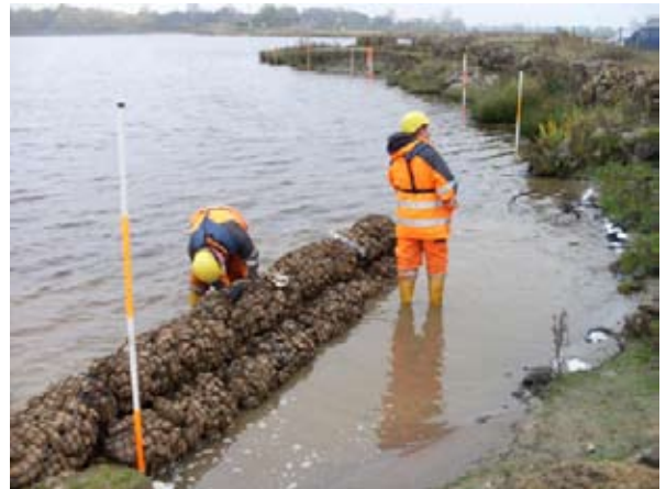
Nettingruller med stein , klar for montering og fylt med frostsikre steinmaterialer i meget slitesterke spesialnettinger. Til erosjonssikring i områder med høye hydrauliske belastninger.
