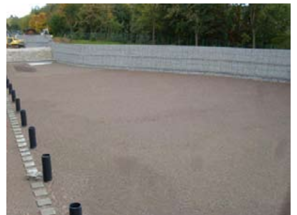
Tomme gabioner av tvinnet metalltråd eller av sveiset, stålforsinket gitter.
