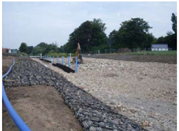
Flodmadrasser/fleksible steinmadrasser , fylt og klar for montering. Egnert for områder som er utsatt for oversvømmelser, både for skråninger og langs vannet. (Kystvern eller lignende)
