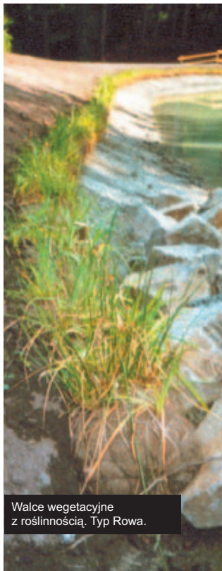
Umocnienie brzegu za pomocą walców VF oraz darni rolowanej GM.
